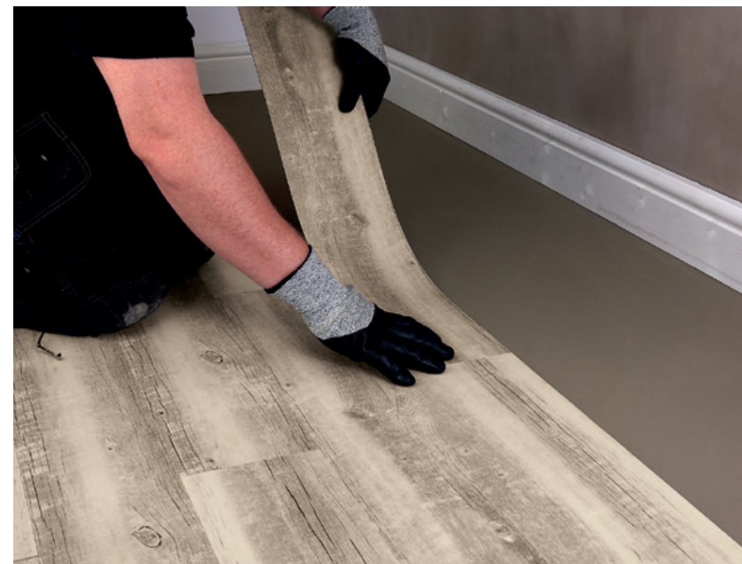
Standardowy montaż - klejenie do podłoża
